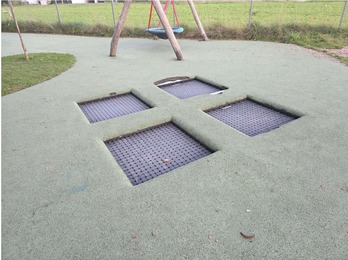
Beschädigter Fallschutz durch Scooter und Velos
