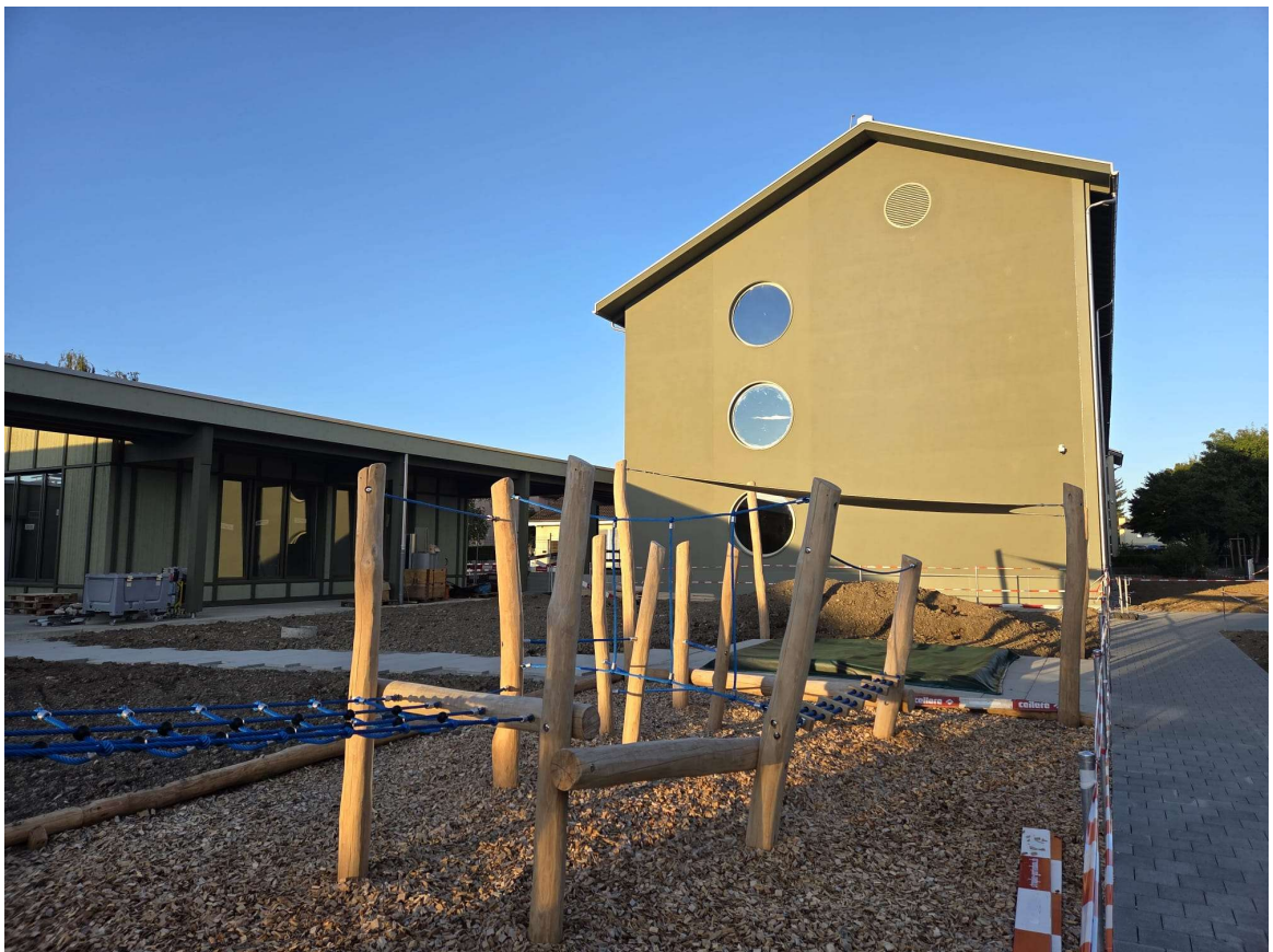
Ansicht Erweiterungsbau Westfassade Anfang September
