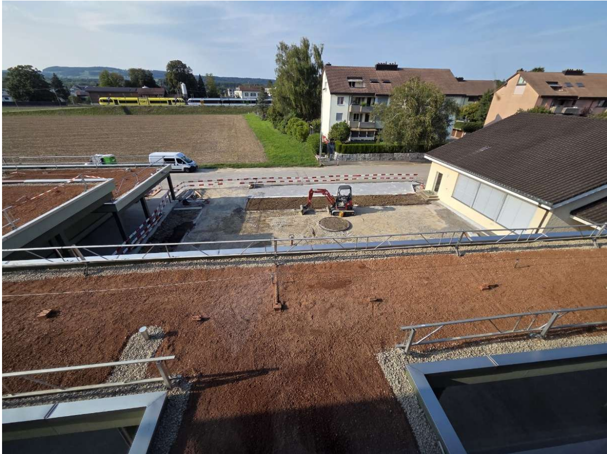
Blick über das Flachdach zum neuen Pausenhof
