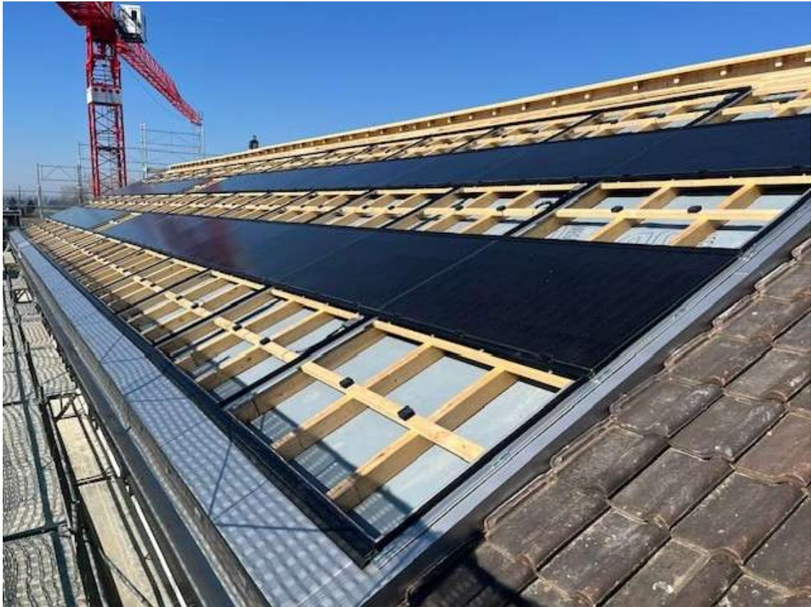
PV-Indachanlage mit Anschlussprofilen zum Altbau.
