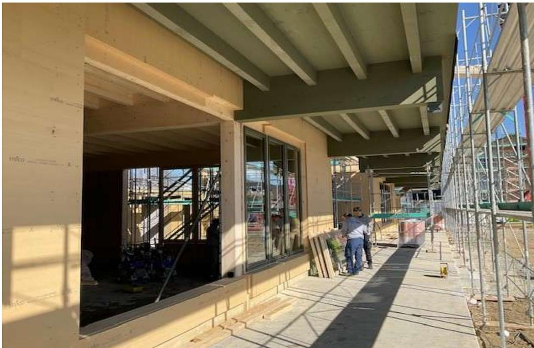
Unter dem grossen Vordach werden schon die ersten Fenster montiert.
