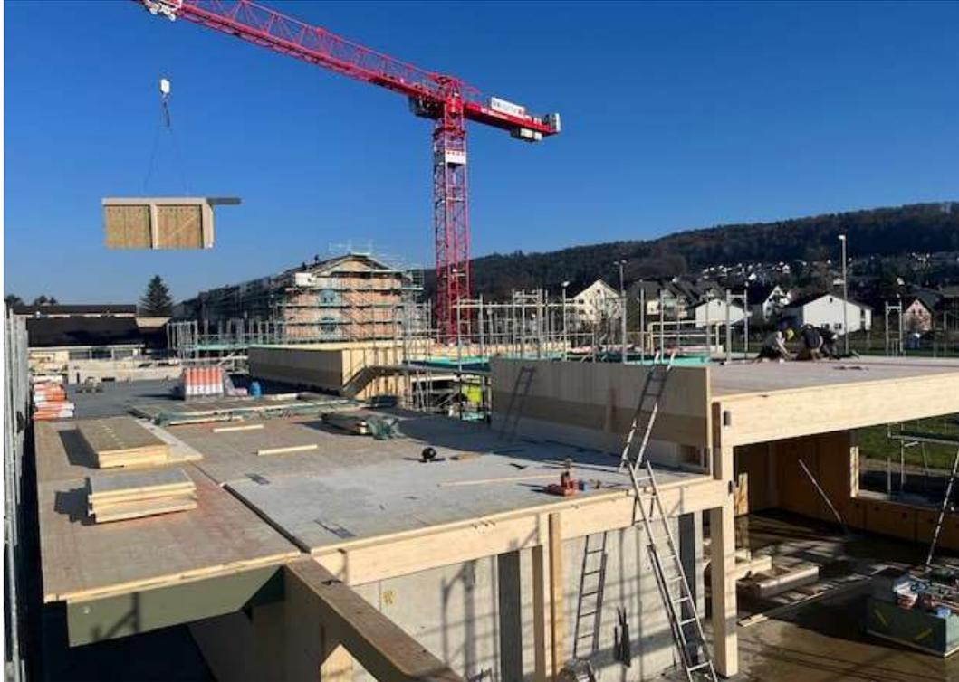
Holzelemente werden mit dem Kran an ihren Platz gebracht und ins Gebäude eingefügt.
