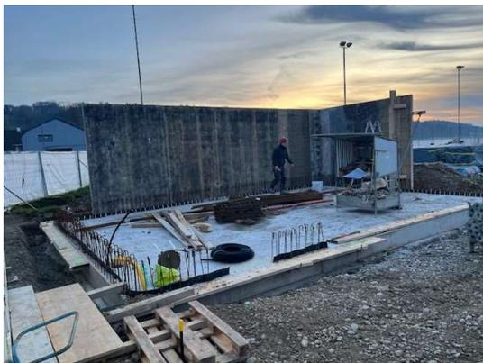
Aussenwände des Geräteraums werden betoniert
