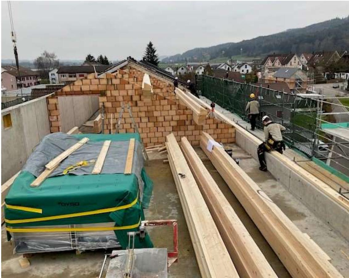
Balken wurden gesetzt und vorher noch die Grossen Bauteile eingebracht (Treppe, Lüftung,...)
