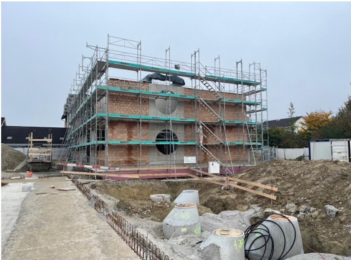
Die Betonwände wurden ausgeschalt. Das Material kann nun gleich ein Stockwerk höher erneut eingesetzt werden.
